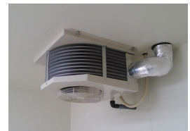
冷蔵ユニット (汎用タイプ)
