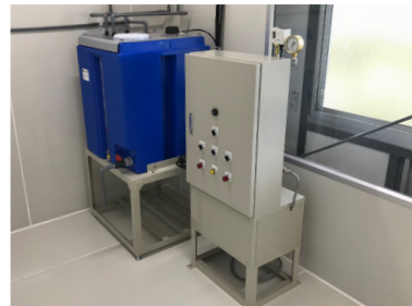
フィルターろ過処理装置
